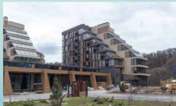
Многоэтажный дом, Московская обл., г. Химки. Наклонный фасад (квартира) — 35 м 2 . Назначение — снеготаяние .
